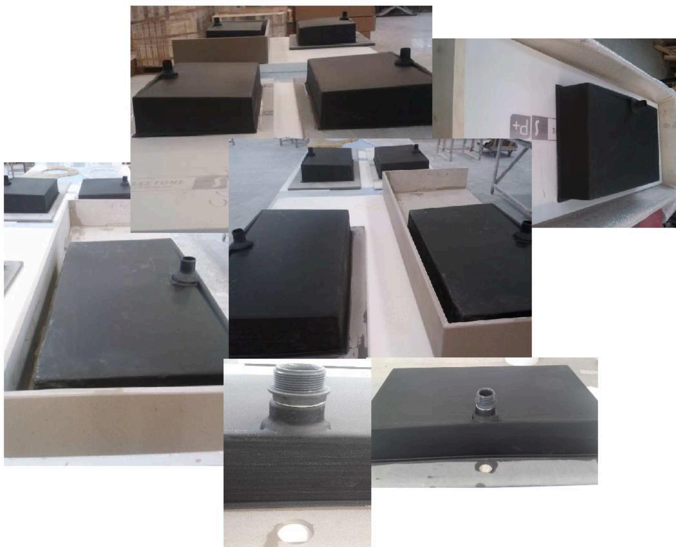
Fase di chiusura del sotto lavabo
